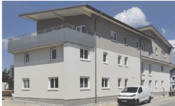
Wohnanlage Weng (Fessler Bau), gebaut mit EDER Vollwertziegel
