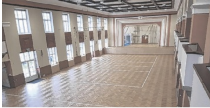
Die Halle erhielt einen neuen Boden.
